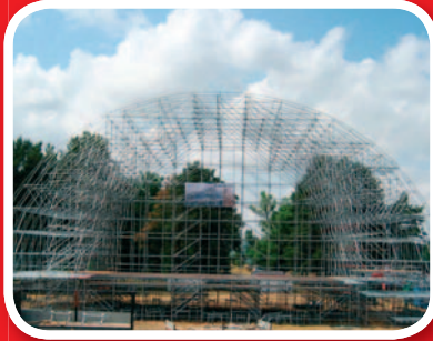
Montaż gigantycznej estrady oraz konstrukcji technicznych pod światło i nagłośnienie.
